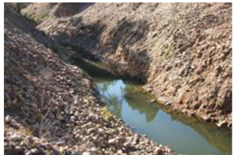
Figura 7. Bolos vertidos en zona excavada
